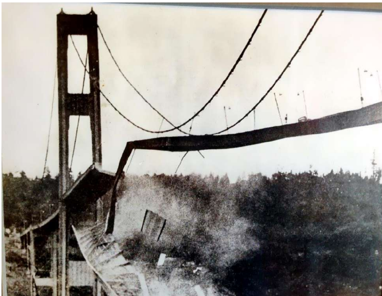
Рисунок 1.2 – Крушение Такомоского моста
