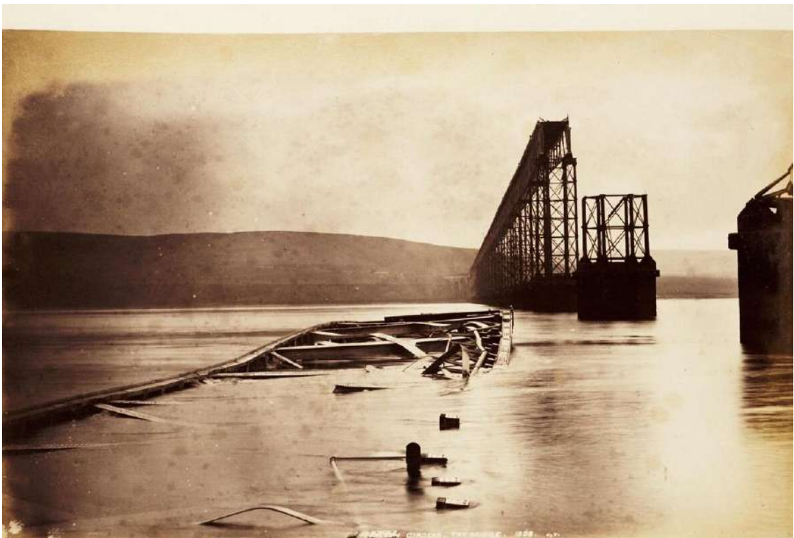
Рисунок 1.1– Крушение железнодорожного моста через Ферг-оф-Тей
