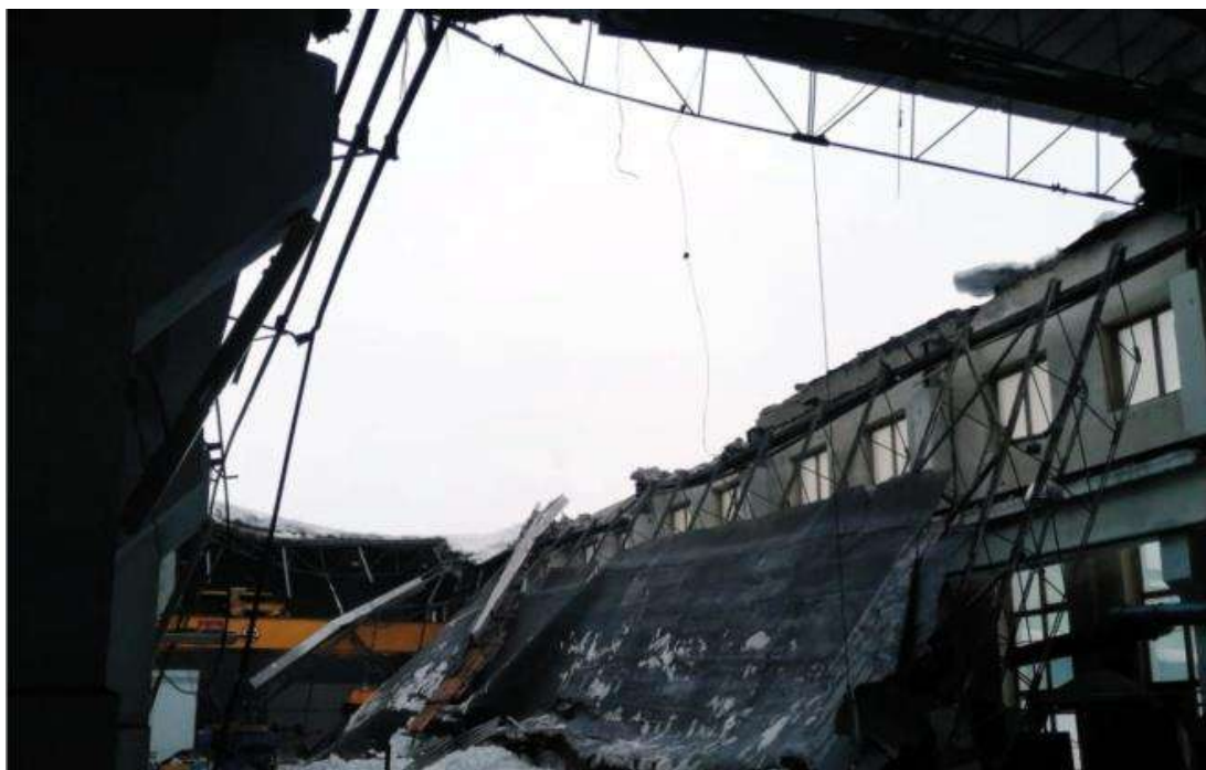
Рисунок 1.14 – Обрушение кровли локомотивного депо на железнодорожной станции (Россия)
