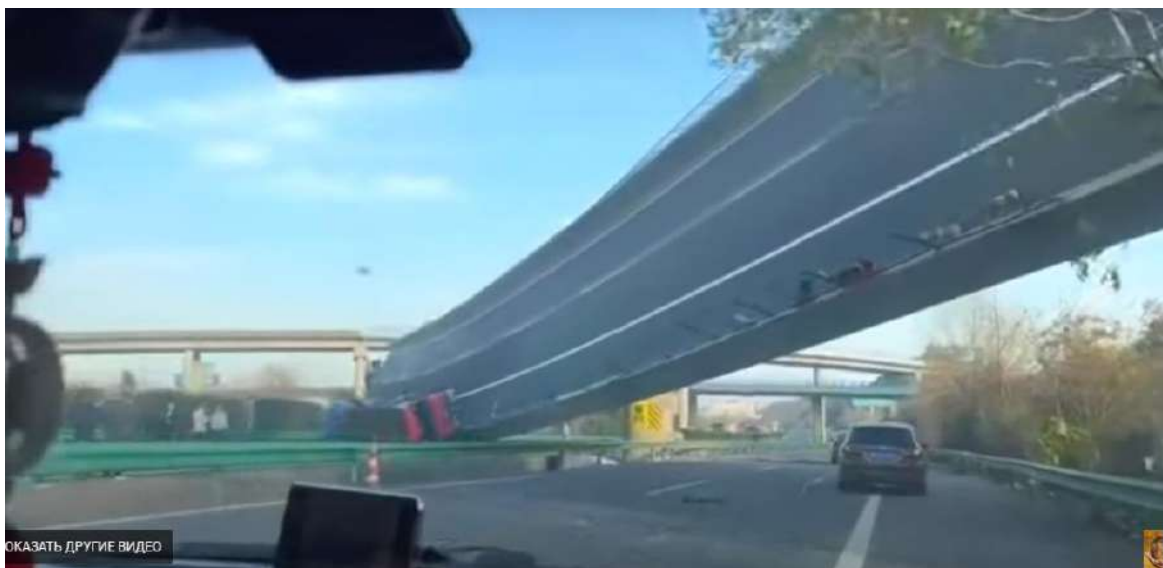
Рисунок 1.4 – Обрушение эстакады моста (Китай)
