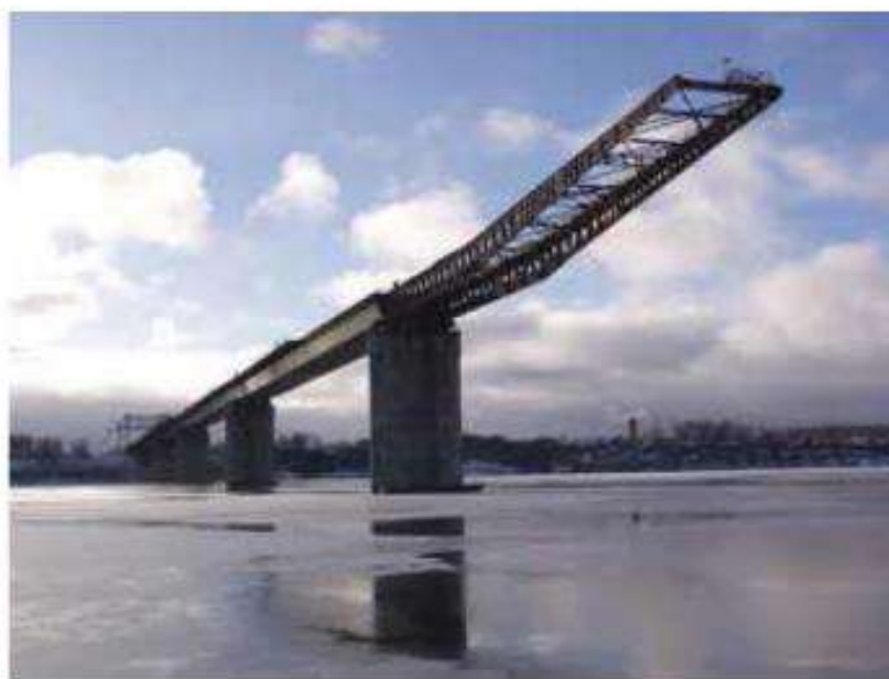
Рисунок 3.47 – Монтаж пролетного строения методом надвижки
