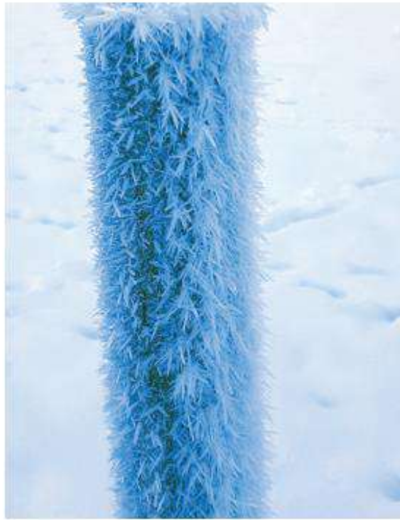
Рисунок 1.21– Кристаллические образования на поверхности деревянных опор ЛЭП малой мощности
