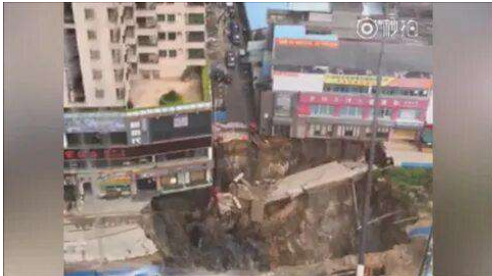
Рисунок 1.8 – Обрушение строящейся станции метро (Китай)
