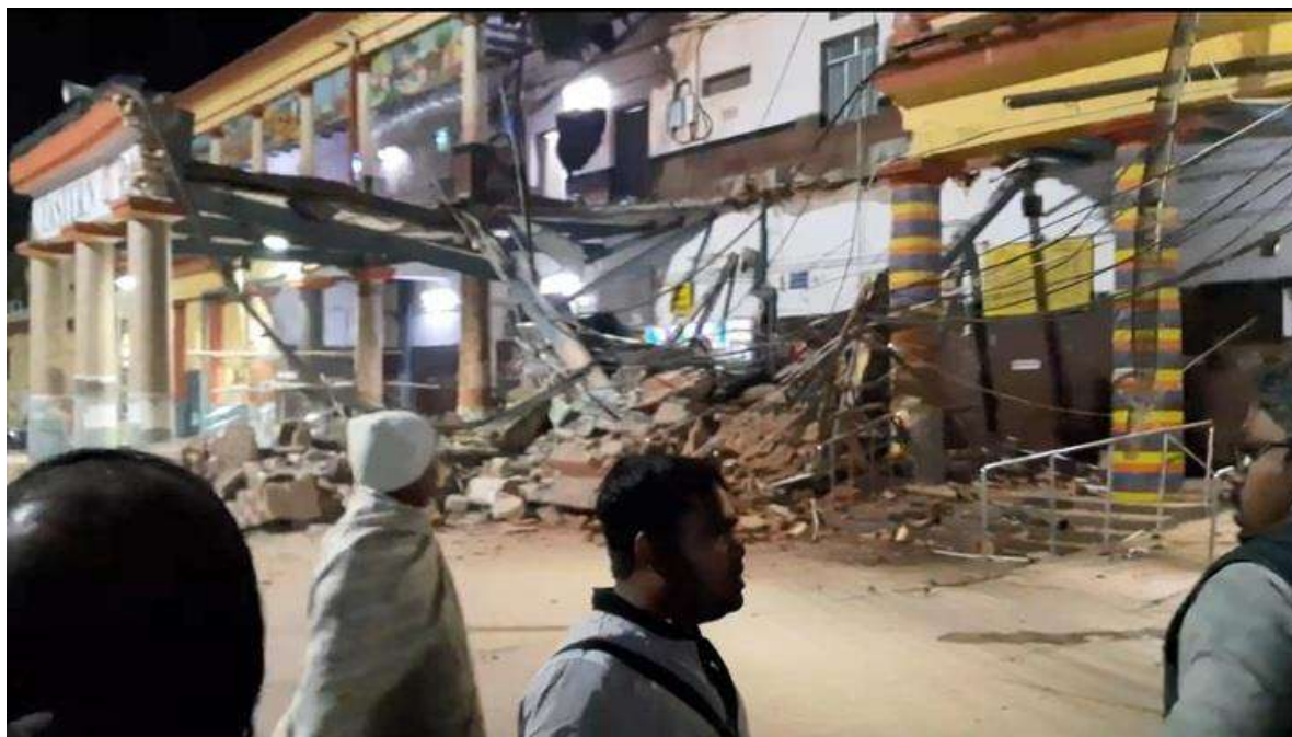
Рисунок 1.12 – Обрушение вокзала (Индия)
